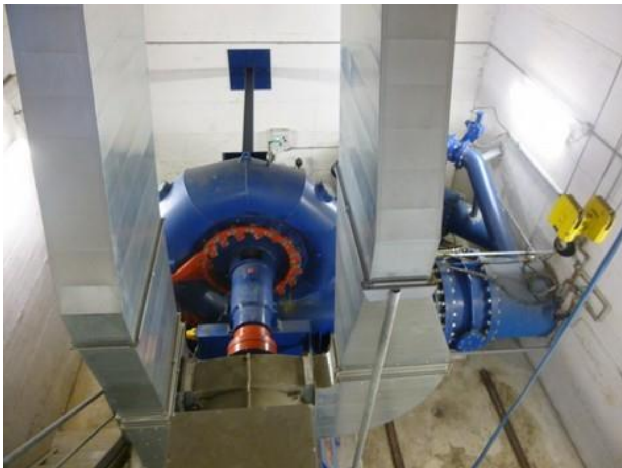
Foto 9: canne di smaltimento dell'aria calda, in alluminio
