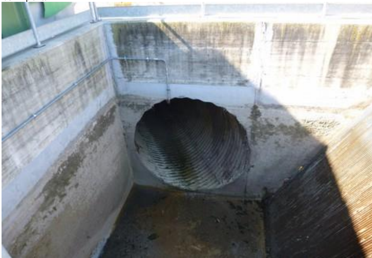
Foto 2: punto di immissione nella vasca di carico
