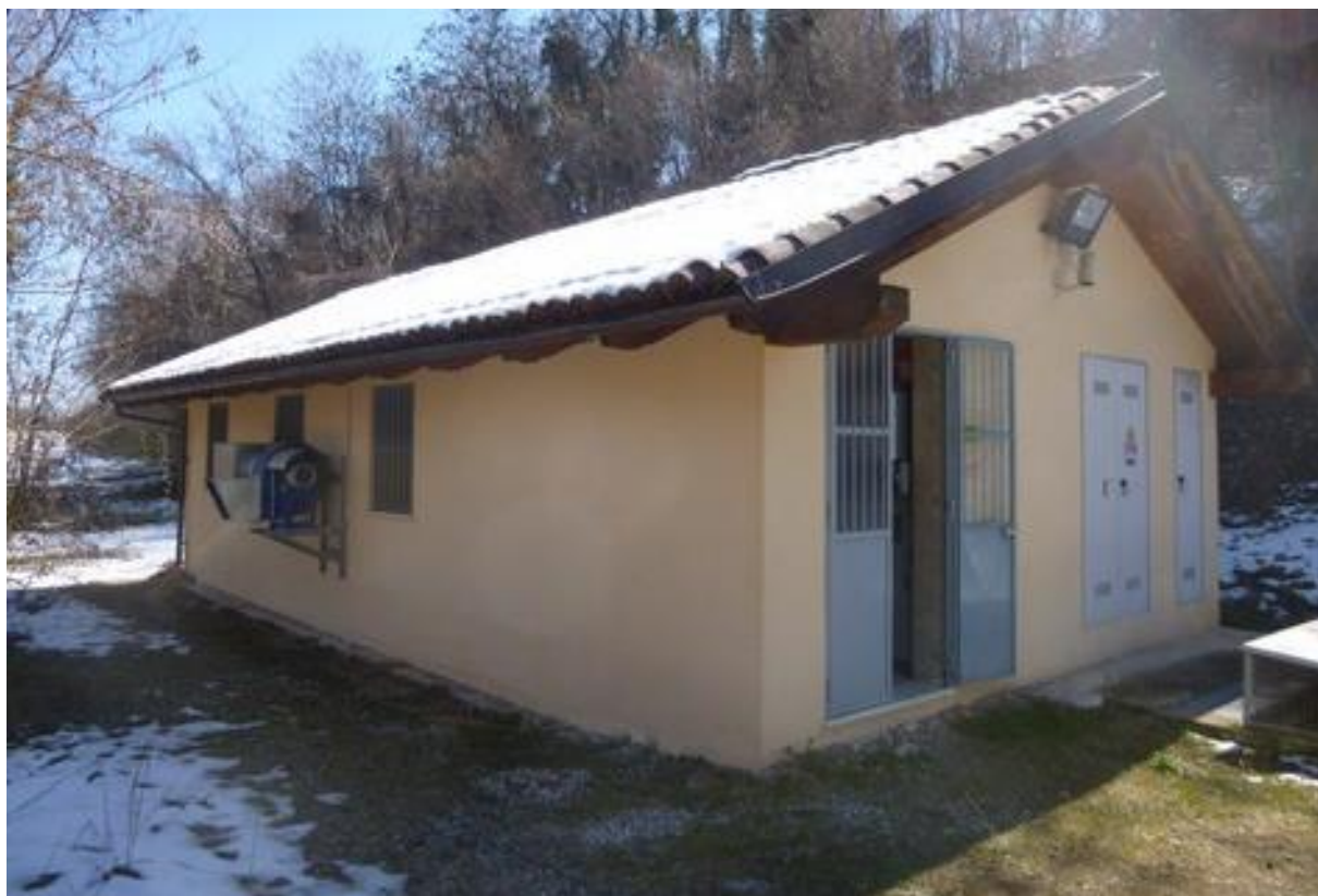
Foto 5: edificio di centrale
